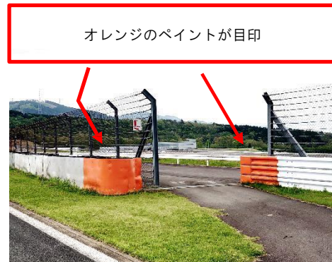
<図 3>サービスロード開口部
